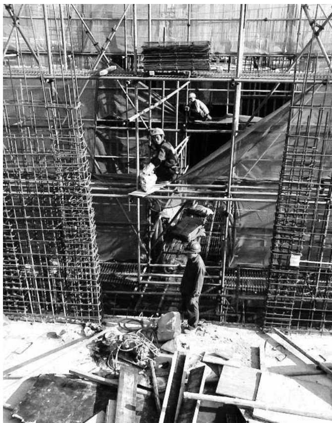
Ouvriers sur un chantier
