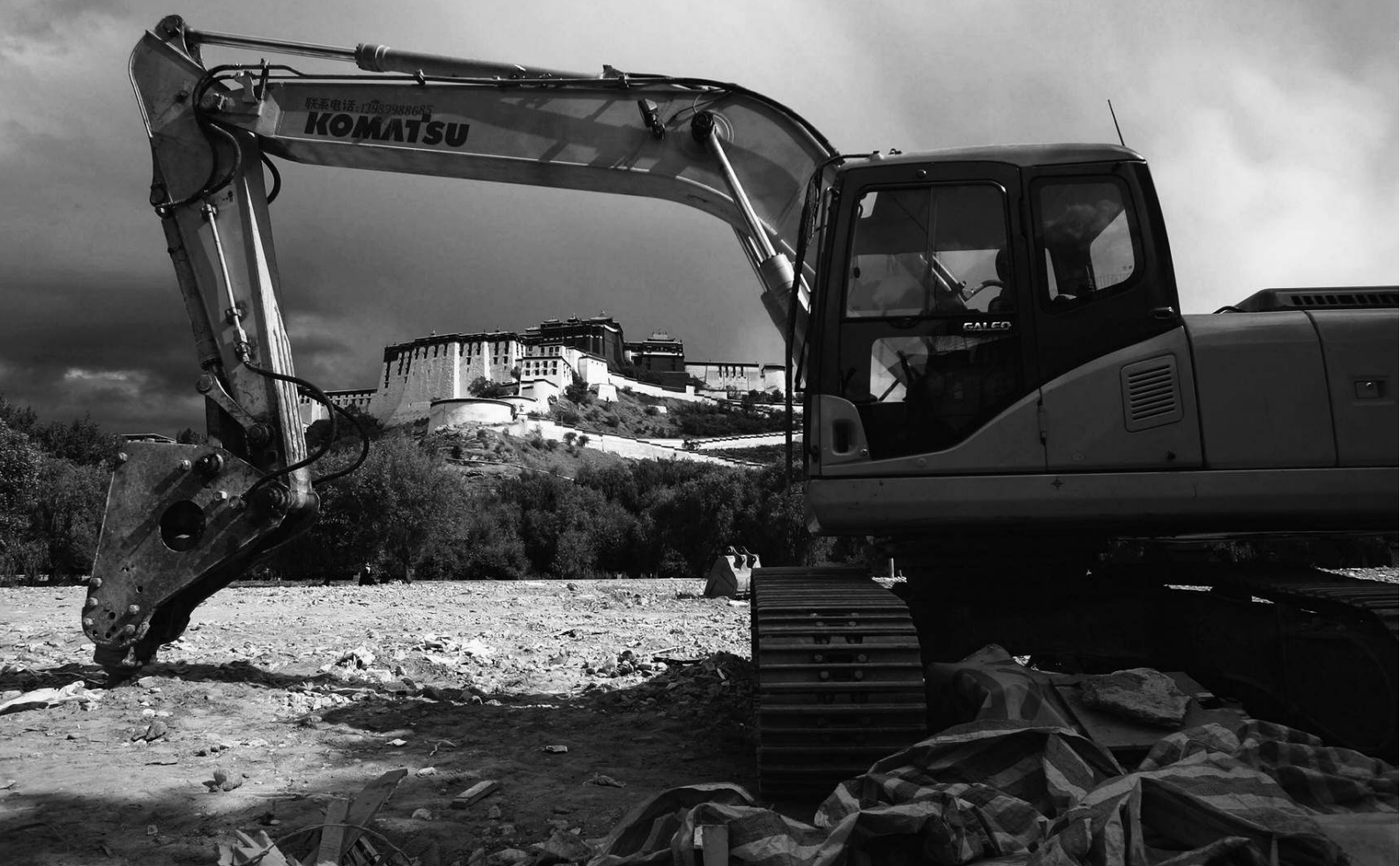
Chantier à proximité du Potala de Lhassa (juin 2006).
