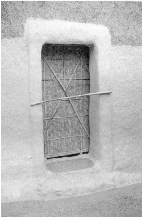
Photo 3. La partie basse du mur de maison est recouverte d'un enduit. La porte est en bambou
