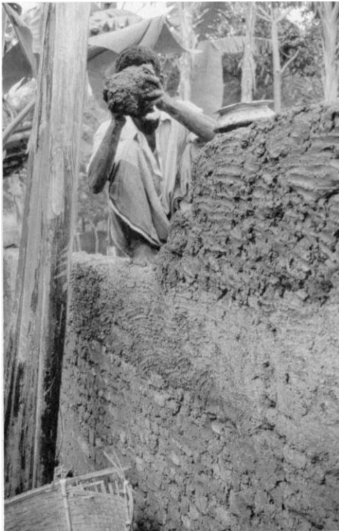
Photo 2. Élévation d'un niveau de construction par la technique de la bauge
