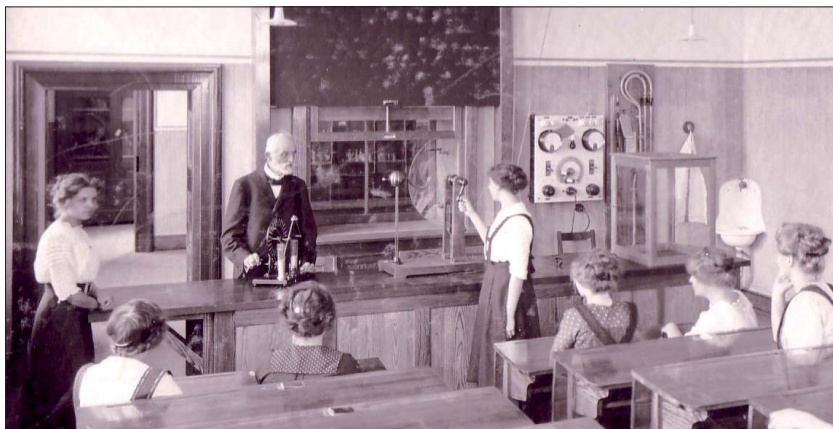
Fig. 10 : un cours de physique à l'école supérieure municipale de filles de Colmar au début des années 1910 (AM Colmar, fonds iconographique, « Lycée Camille Sée », détail de la photographie). L'enseignant actionne une machine de Wimshurst, l'élève une machine de Winter.
