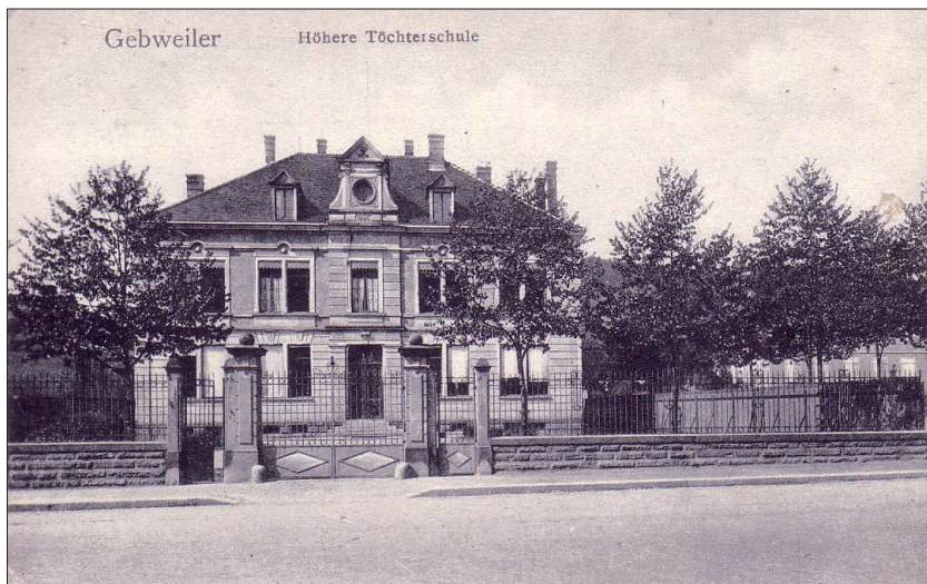
Fig. 4 : L'école supérieure municipale de filles de Guebwiller au début du XX e siècle (AM Guebwiller 8Fi22). La construction de ce nouveau bâtiment au début des années 1890, financée par la commune, donne lieu à la municipalisation de l'établissement une fois les travaux achevés, en 1895. Après 1918, le bâtiment abrite l'école primaire supérieure de jeunes filles, puis une école maternelle, jusqu'à l'installation du Conseil des Prud'hommes en 1983.
