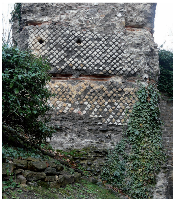
Fig. 10. Réticulé en calcaire jaune du Mont d'Or (pierre de Couzon), sur une des piles du réservoir de chasse, dans le fort Saint-Irénée. L'appareil très irrégulier semble dénoter une restauration (cliché A. Desbat).
