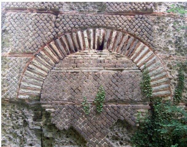
Fig. 8. Une des piles du pont du Garon à Brignais, avec le bouchage des arches réalisé dans un second temps mais avec le même mode de construction (cliché A. Desbat).
