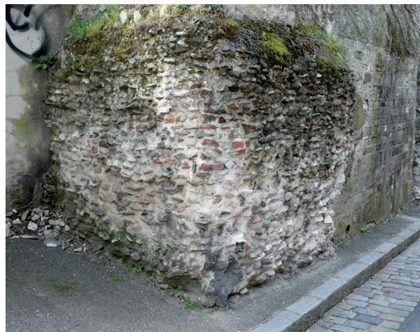
Fig. 9. Fondation de la pile n° 4, rue Roger Radisson. À la différence des autres piles, elle est constituée de matériaux hétérogènes (cliché A. Desbat).
