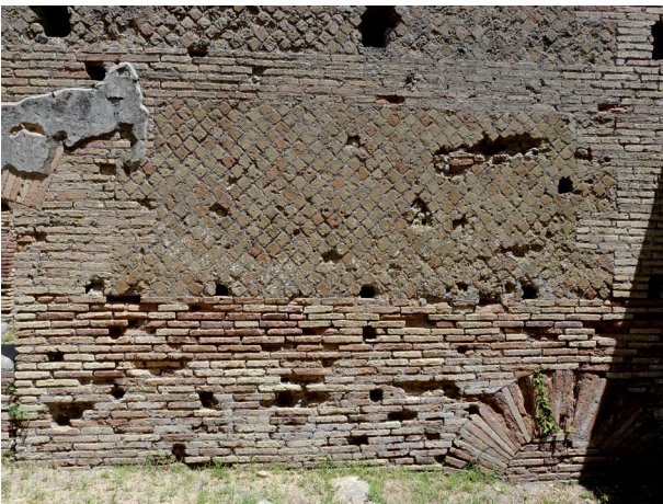
Fig. 4. Ostie : mur en opus mixtum, du I er siècle, via delle Taberne finestrata (cliché A. Desbat).
