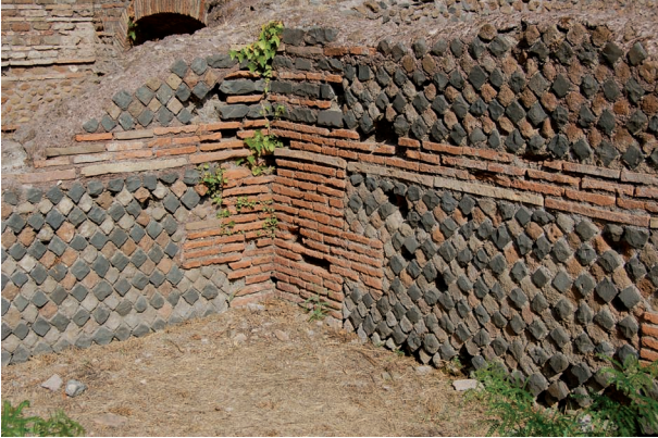
Fig. 3. Mausolée d'Ostie avec appareil réticulé bichrome (cliché A. Desbat).
