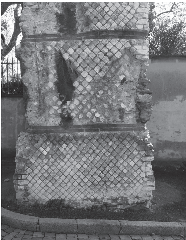
Fig. 6. Pile de l'aqueduc du Gier, rue Roger Radisson à Lyon, avec des cubilia de deux modules : 7 cm de côté pour la partie inférieure et 10 cm pour les parties hautes (cliché A. Desbat).
