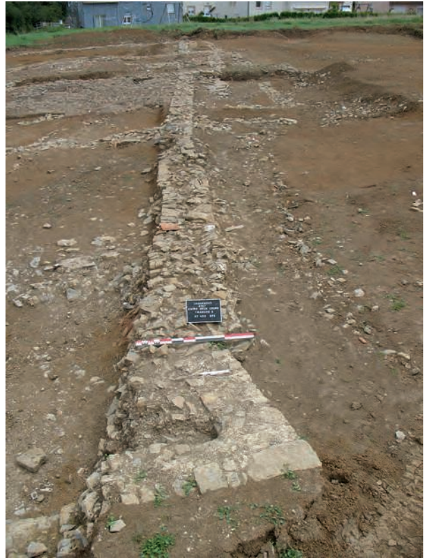
Fig. 35. Bâtiment 1, angle sud-ouest, exemple de chronologie relative à travers l'observation de deux maçonneries (photo : S. Jeandemange, Inrap).
