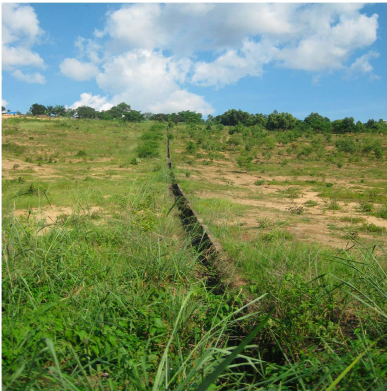
Figure 5. Collecteurs d'eau de pluies construits entre 1969 et 1971 en remplacement des bassins de rétention.
