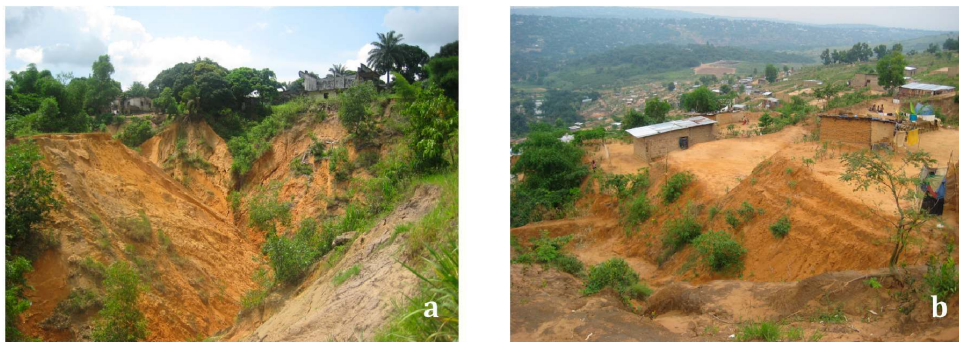
Figure 2. Ravin apparu suite à l'inachèvement d'un collecteur (a) Aménagement urbain en terrasse sur site sensible à l'érosion (b).
