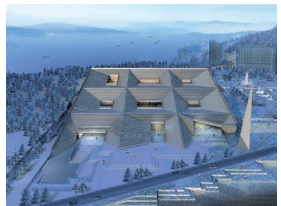
fig. 6 Le toit du centre culturel de Yuyang : la structure est inspirée du symbole traditionnel chinois dit du «quadrillage des neuf palais».
