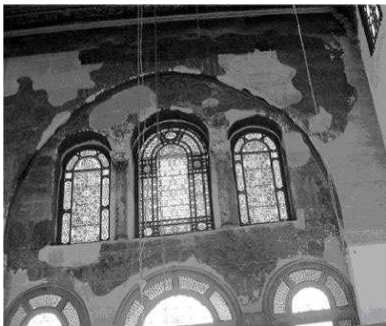
Fig. 3 - Vue d'ensemble du mur pignon à l'intérieur.
