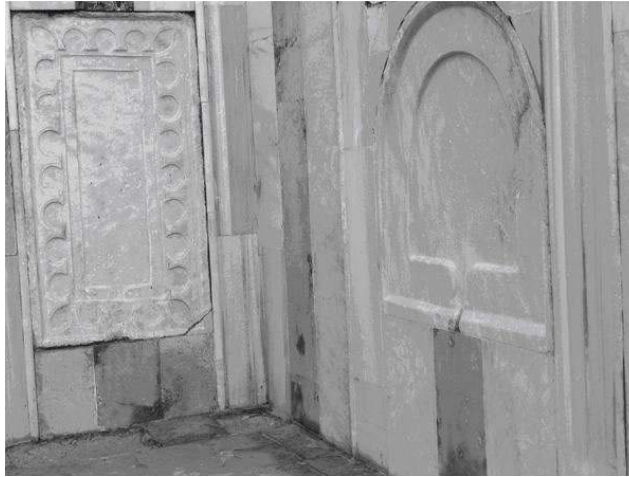
Fig. 19 - Tables de marbre en remploi dans le décor de l' īwān sud du Māristān de Nūr al-Dīn.
