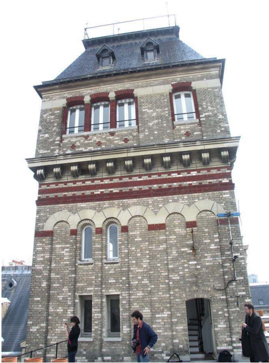
Tour de Physique de la nouvelle Sorbonne. Phot. Christelle Inizan. © CRMH Île-de-France, 2009.
