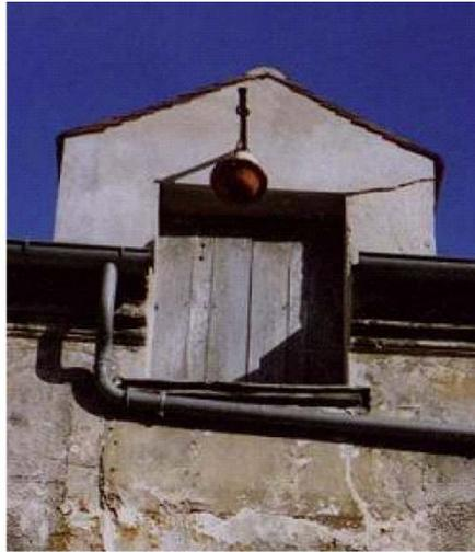
Fig. 5 : 68 rue de Rosny, détail de l'ouverture du grenier, au-dessus de laquelle subsistent les traces d'une poulie
