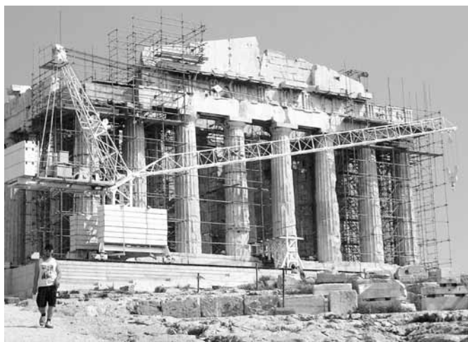
20. Façade ouest du Parthénon : démontage des angles jusqu'au niveau des métopes.
