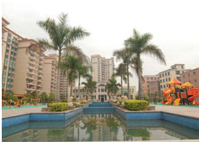
Photo 1 – Trois des dix immeubles d'appartements dans la cité résidentielle pour les villageois Chen d'origine. Sur la droite se trouve une institution pour personnes âgées Chen et les immeubles de services pour le lotissement. © Tom Cliff
