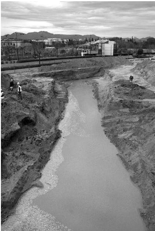
Fig. n°1 : Vue verticale et oblique du fossé depuis le sud-est. La partie ennoyée par la nappe phréatique correspond au fond du fossé
