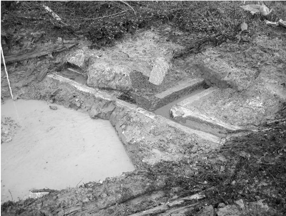
Fig. n°1 : Intersection des deux aqueducs
