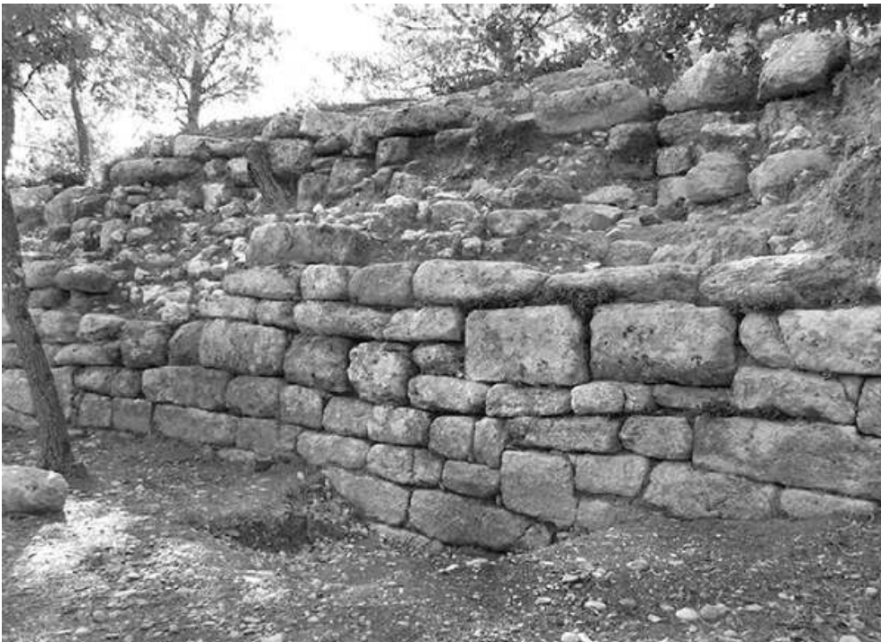
Fig. n°3 : Zone 8000 : fondations de la courtine orientale, extrémité nord
