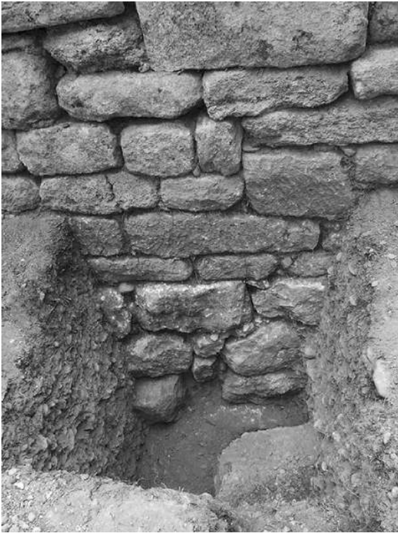
Fig. n°2 : Zone 7000 : courtine orientale, extrémité nord
