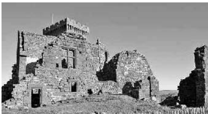
Fig. n°2 : Façade sud du logis dénommé « la Seigneurie »
