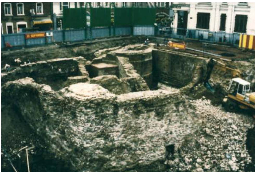
Fig. n°1 : Vue de la tour nord de la Porte d'Arras
