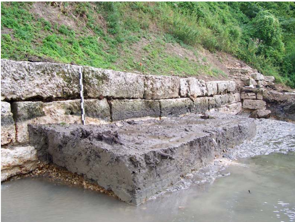
Fig. n°2 : Vue en coupe de l'US 1002 au contact de l'aménagement MR1005 (secteur C – sondage 1), prise du nord-est
