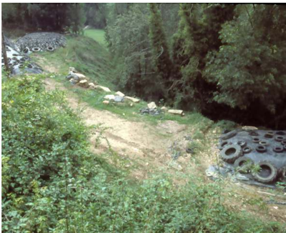
Fig. n°2 : Vue générale, depuis la RD 142, des blocs mobilisés.
