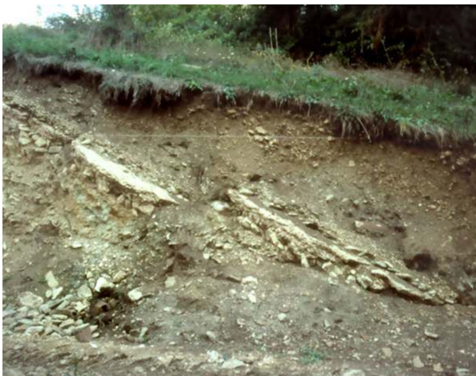
Fig. n°13 : Zone A2, le sol de tuileau rose disloqué par le glissement du terrain.
