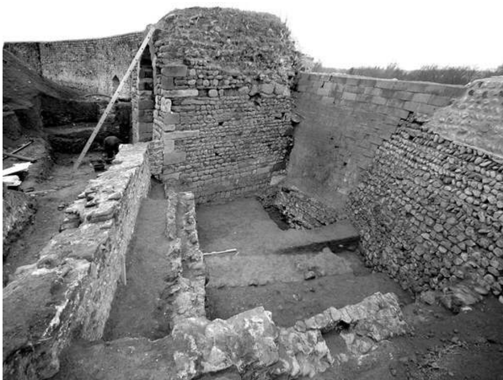
Fig. n°2 : Vue d'une partie des bâtiments successifs construits contre la courtine de la basse-cour
