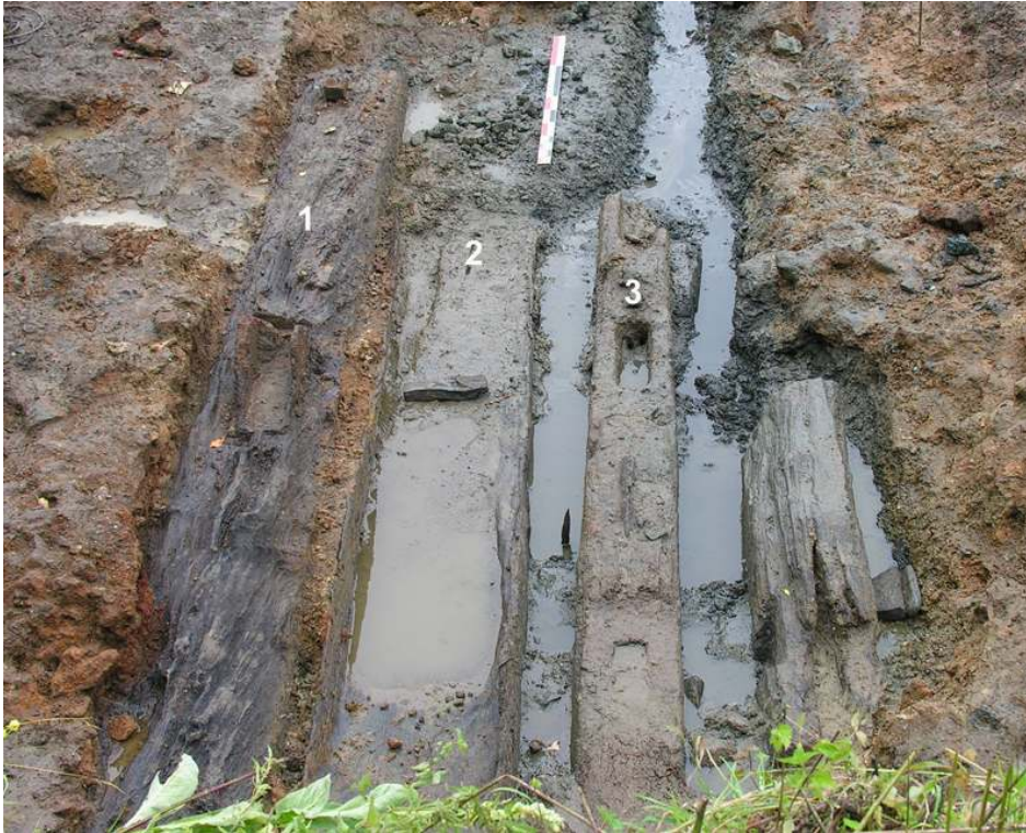
Fig. n°1 : Ensemble des poutres associées au gros manteau, vu depuis la digue : 1 : extrémité de l'ordon 2 : emplacement de la roue 3 : support de l'arbre de la roue
