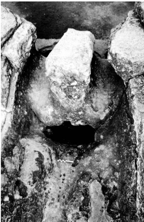
Fig. n°13 : Ouverture placée au-dessus du canal de vidange et rétrécie par des dépôts carbonatés
