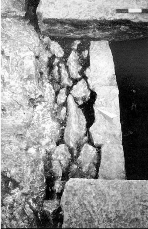
Fig. n°10 : Structure du piédroit du canal de vidange
