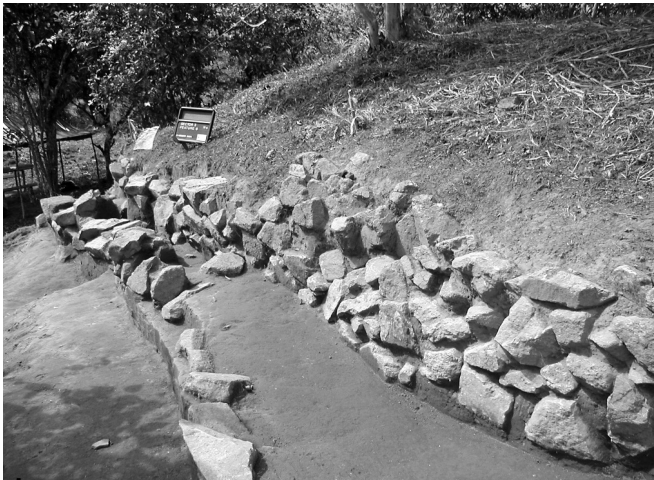
Figura 3 – Un muro de retención (no reconstruido) hecho por los incas en el talud occidental de la Terraza 3
