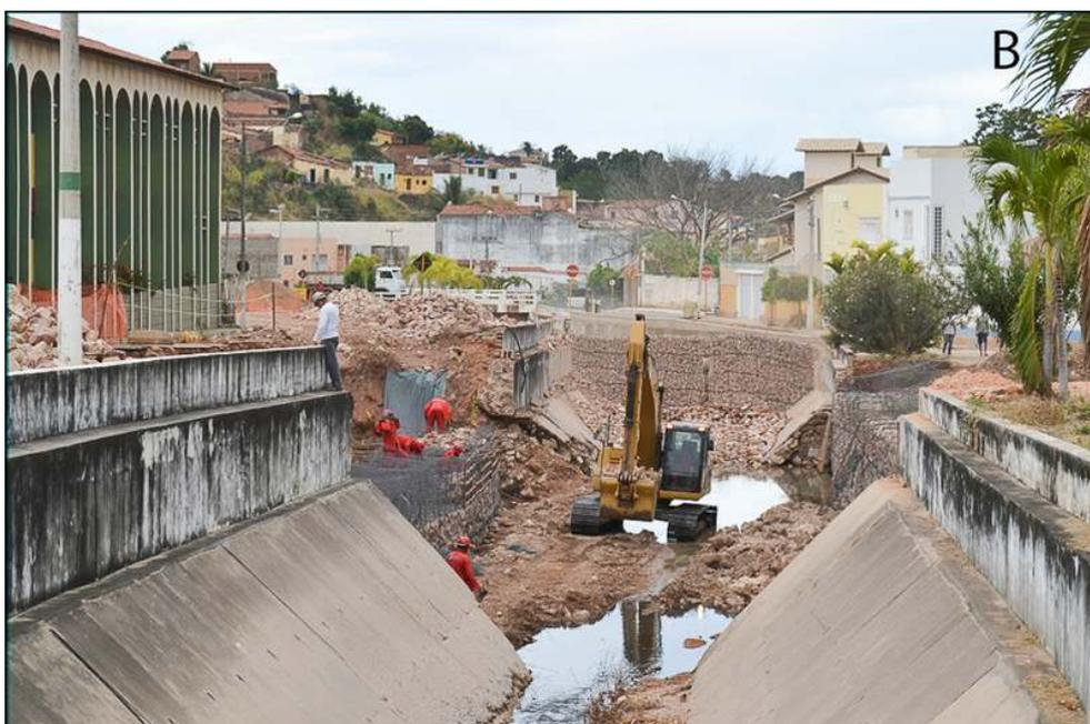
Pose de gabions à même le lit du cours d'eau dans les tronçons détruits par la crue de janvier 2011. Maintien de la section trapézoïdale ailleurs, ainsi que des ponts trop bas, induisant des variations de forme transversale et de calibre propices à une accentuation des turbulences et de la puissance érosive de l'écoulement de crue.
