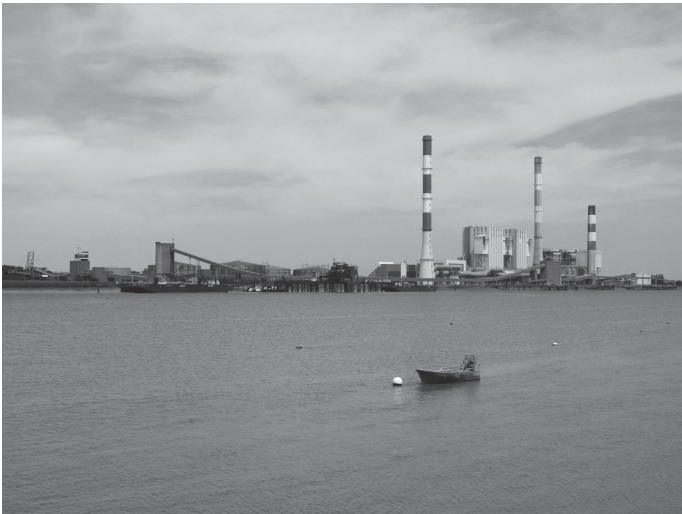
Figure 1 : La centrale de Cordemais vue de l'autre rive de l'estuaire de la Loire (Photo de Clément Colin, juin 2010) View of Cordemais coal plant from the other side of the Loire estuary
