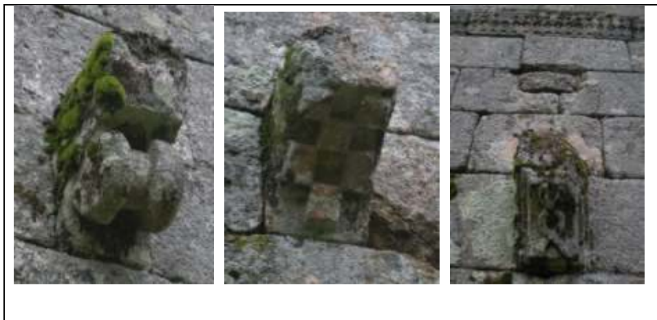
Fig. 12 – Exemplos de cachorros da fachada lateral Sul.
