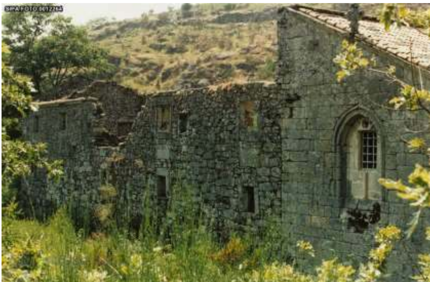
Fig. 13 – Fachada oriental da igreja [ www.monumentos.pt ].
