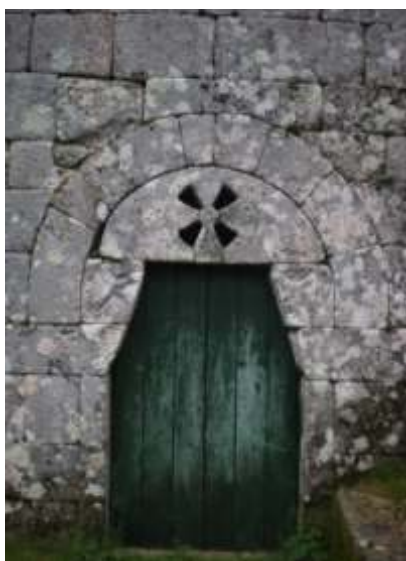
Fig. 6 – Portal lateral Sul.
