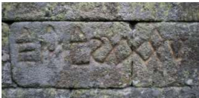
Fig. 2 – Inscrição da fachada lateral Norte da igreja 17 .
