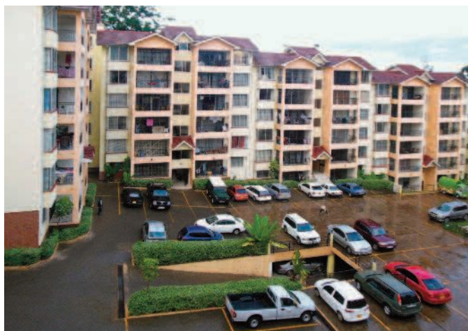
Photo 3 – Les immeubles de la résidence Sunhills Apartments. © David Bénazéraf
