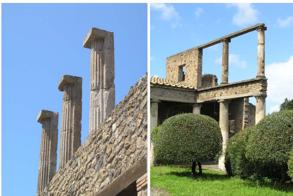
Fig. 6 - Exemple de piliers à demi-colonnes engagées à gauche et de colonnes libres à droite.
