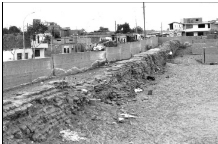
Figura 2 – Vista de la segunda muralla-Puente Lurín antes de iniciar los trabajos de excavación
