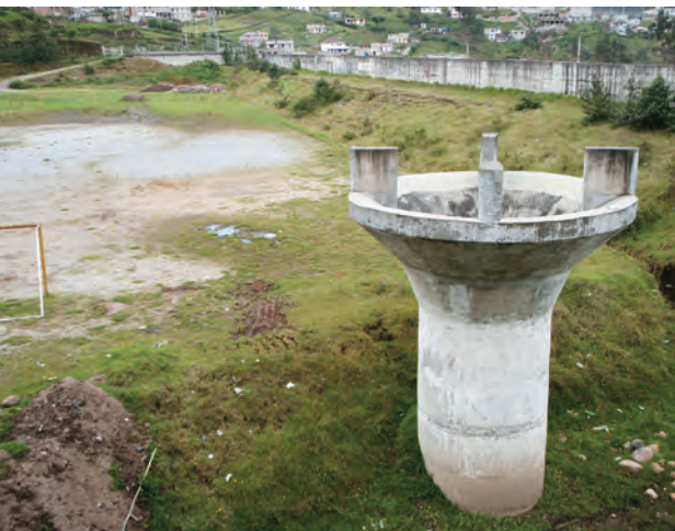
Figura 1 – Obras de protección en la quebrada Rumihurcu
