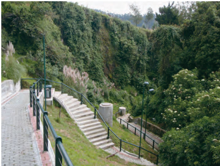
Figura 2 – Acondicionamiento del Parque El Tejar en la quebrada del mismo nombre
