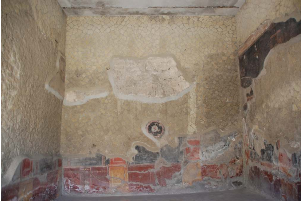
Fig. 5 – Vue de l'intérieur de la pièce [2] casa dell'Atrio Corinzio (V, 30), avec la paroi ouest au centre et les parois S et N de part et d'autre.
