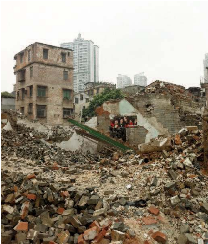
Photo 2 – Bâtiments démolis sur le site de Xiguanlu. © Bettina Gransow
