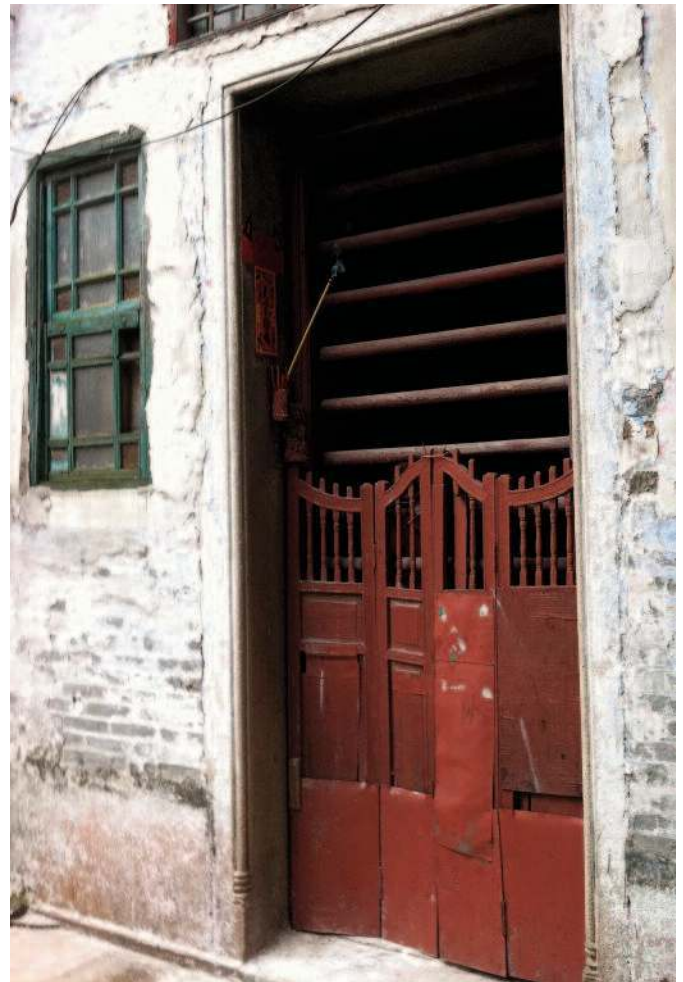
Photo 1 – Une porte en trois parties traditionnelle d'un bâtiment de Xiguan. © Bettina Gransow
