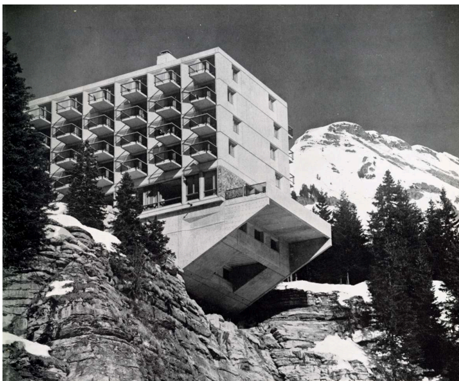
Arâches-la-Frasse (Haute-Savoie) : hôtel Le Flaine, par Marcel Breuer, 1966-1968. Extrait de Techniques et Architecture , 1969, n° 4.
