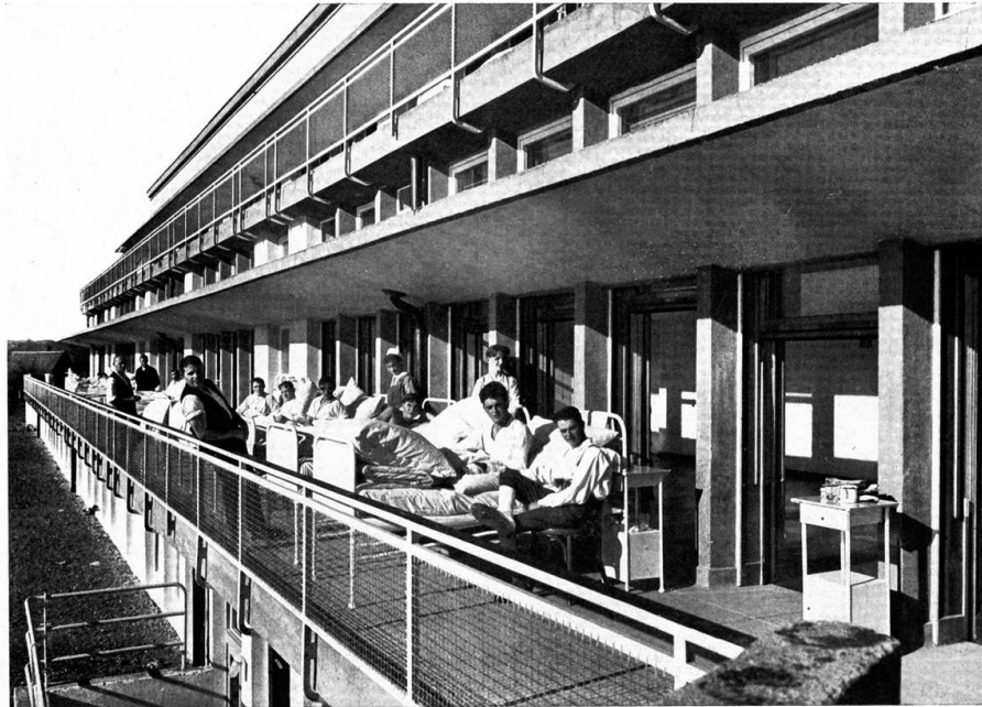
Krankenhaus Waiblingen: Erdgeschossterrasse an einem Sonntag im November 1928. Einblick rechts in das dahinter liegende leere Krankenzimmer, Besonnung desselben durch die über dem Schutzdach angeordneten Oberlichtfenster. Bei dem niedrigen Sonnenstand vollständige Besonnung der Terrasse.
