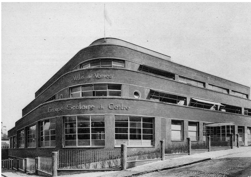
Vanves (Hauts-de-Seine), école primaire de filles, élévations sur rue. Encyclopédie de l'architecture , tome X : Écoles et établissements d'enseignement , 2 e série. Paris : Albert Morancé [1939], pl. 5.
