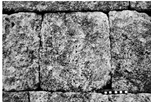
Figure 29. Joint sinueux sur un bloc du Palais royal ajusté à la scie à joint, Ougarit (© Mission de Ras Shamra, J.-Cl. B.).
