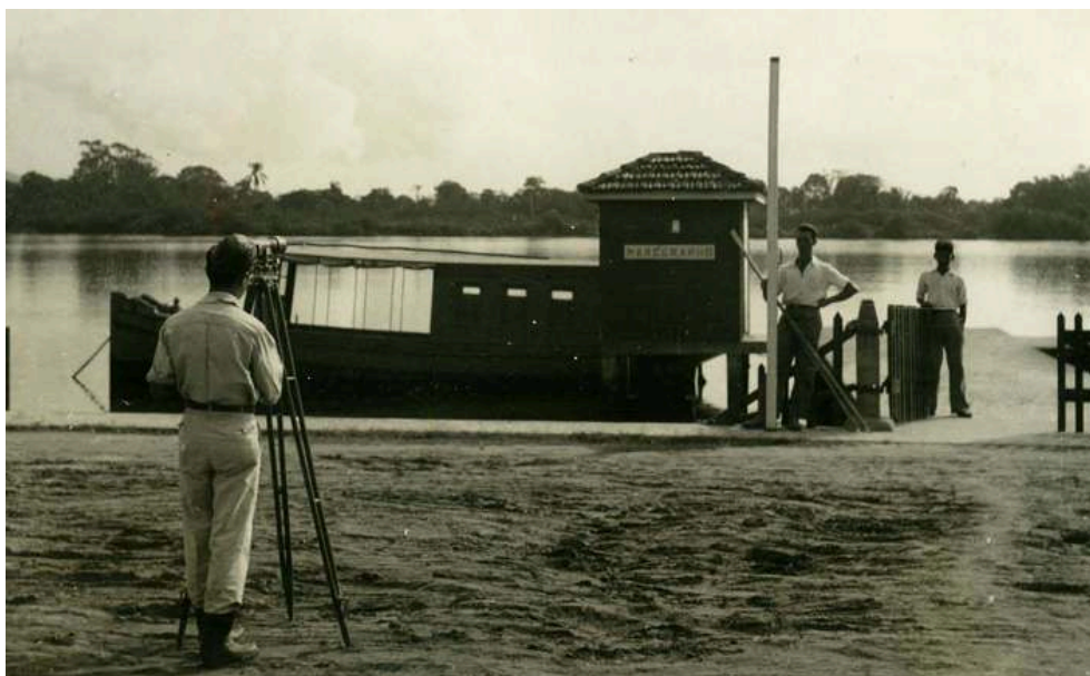
Figura 3 – Medição de nivelamento geométrico próxima ao marégrafo de Itajaí
