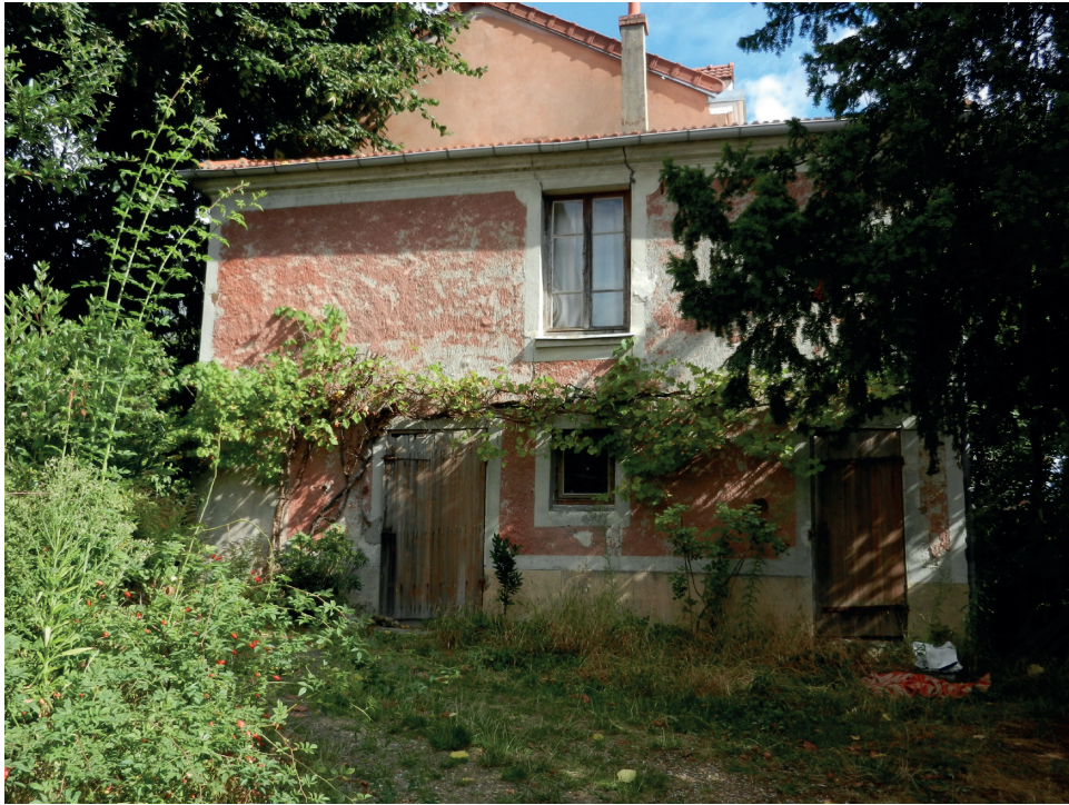
Vue du bâtiment annexe situé à l'Est de la maison (Photo MdL)
