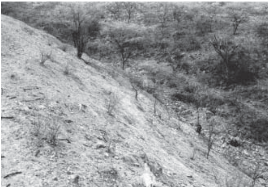
Fig. 15 – Muro de contención del reservorio del Boliche y lecho de la quebrada.
