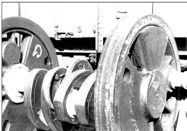
Figure 1. À l'atelier des roues d'Oullins-Machines. Les contraintes de la sécurité et la nécessité d'obtenir des alliages très fiables ont amené la Compagnie du PLM à conserver l'activité de fabrication des roues au sein de ses ateliers pourtant consacrés exclusivement aux activités de réparation. Cl. Ch. Chevandier, 1986.
