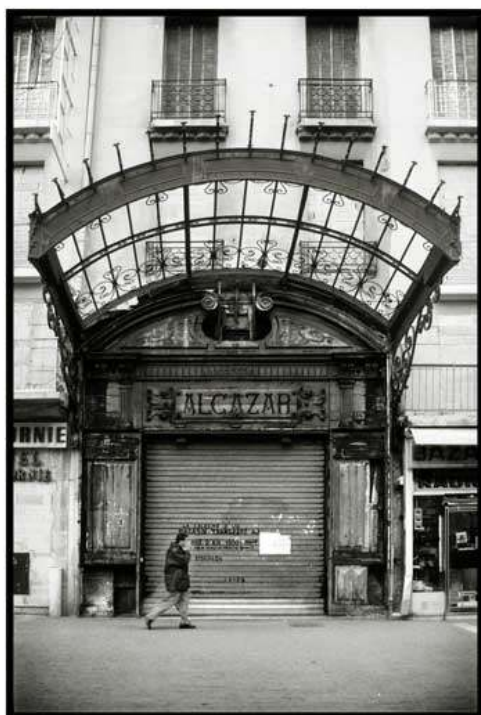
Figure 5. Entrée de l'Alcazar avant sa rénovation, 1994.
