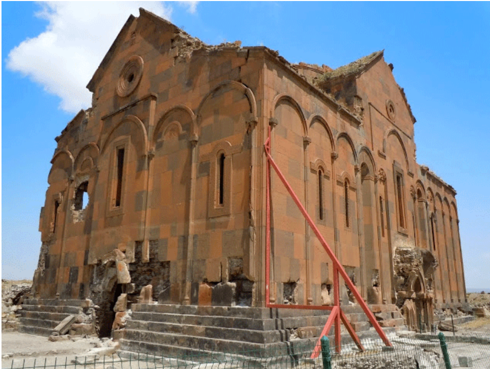
Ani, Cathédrale vue du sud-ouest. Noter l'étrayage métallique de couleur rouge Collection particulière
