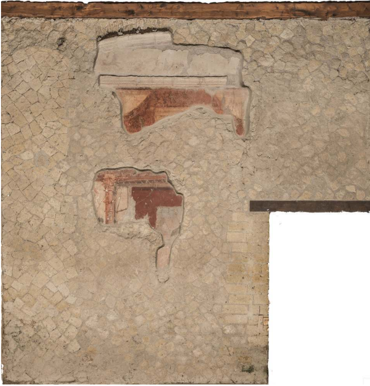
Fig.6 – Orthophotographie du mur est de la pièce 7.
