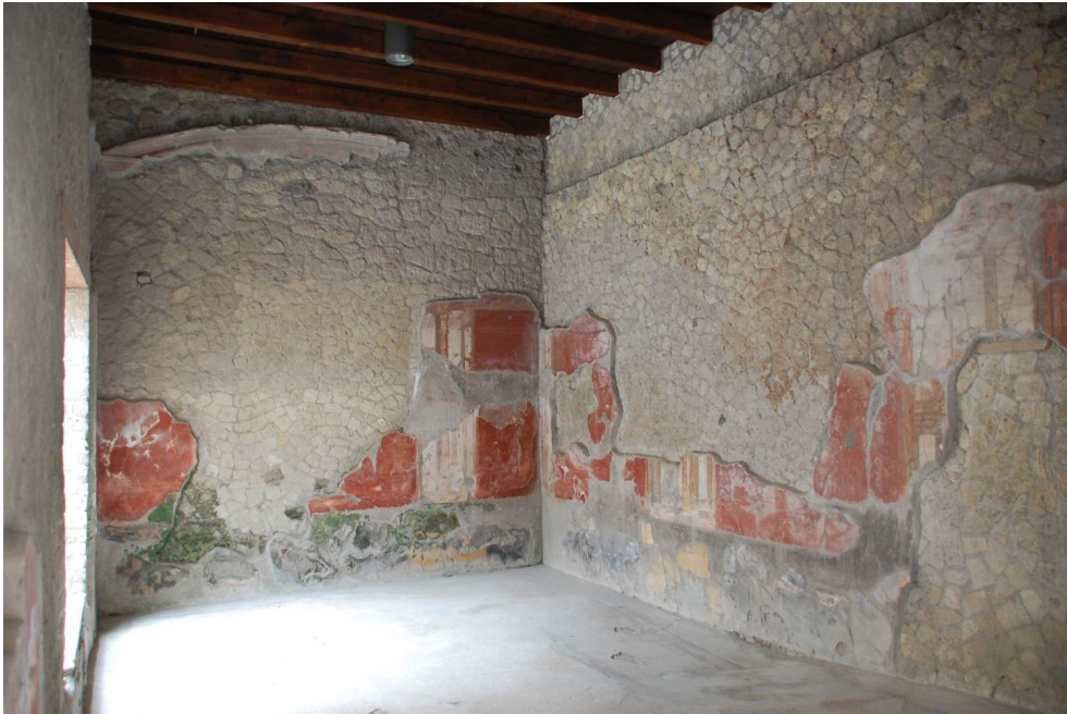
Fig.5 – Vue générale de la pièce 7.
