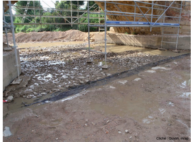
Fig. 10 : Vue du radier général au niveau de l'arche A3 (cliché : Guyon, Inrap).
