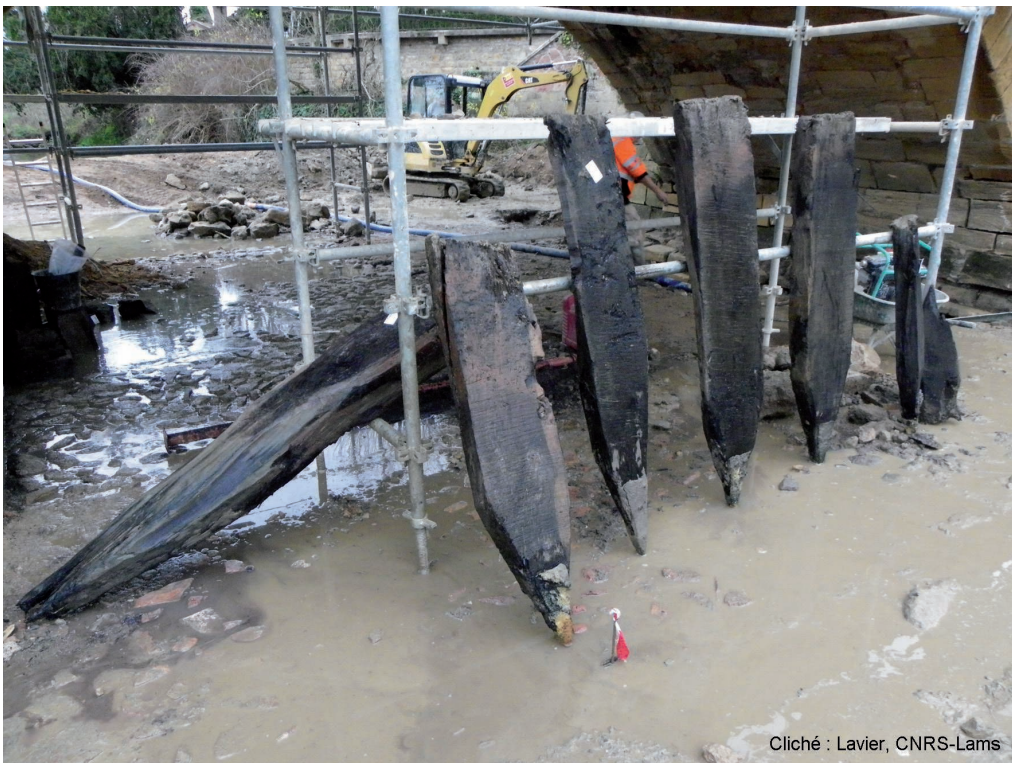
Fig. 25 : Palplanches après extraction (cliché : Lavier, CNRS-Lams).
