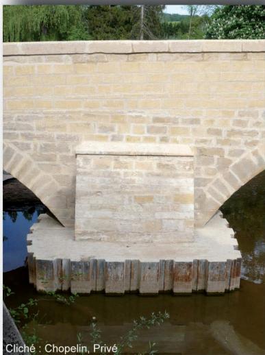
Fig. 22 : Consolidation en béton de la pile P4, fin 2011 (clichés : Chopelin, Privé - DAO M. Guyon, Inrap).
