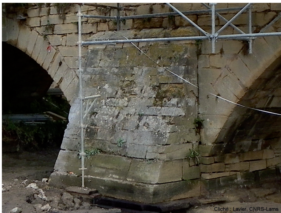
Fig. 34 : Arrière-bec de la pile P4 (cliché : Lavier, CNRS-Lams).
