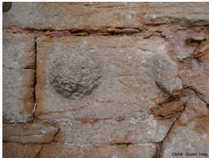
Fig. 20 : Détail du relief lapidaire au niveau de l'arrière-bec de la pile P1 (cliché : Guyon, Inrap).
