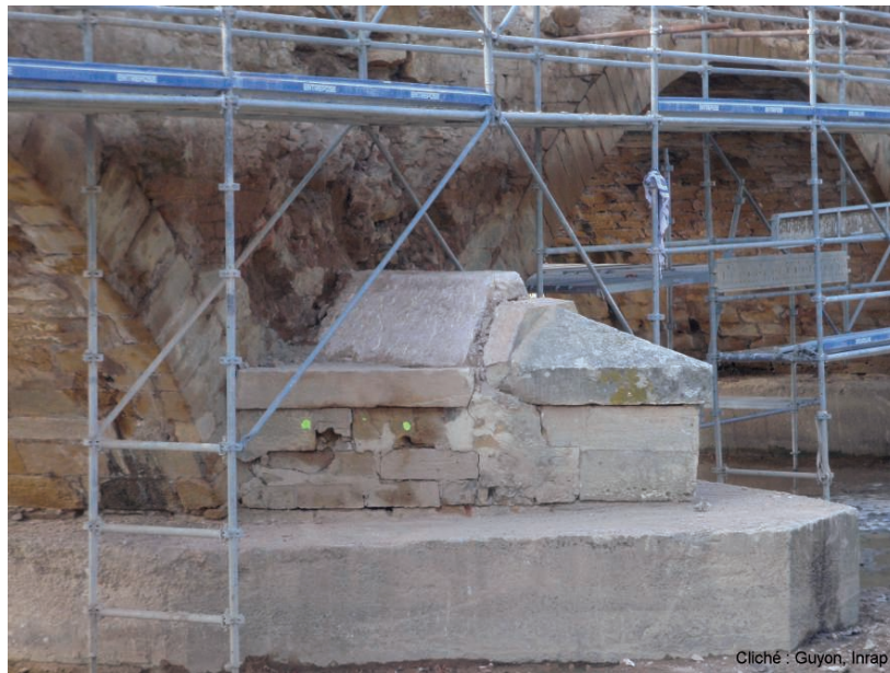
Fig. 6 : Avant-bec de la pile P2 (cliché : Guyon, Inrap).
