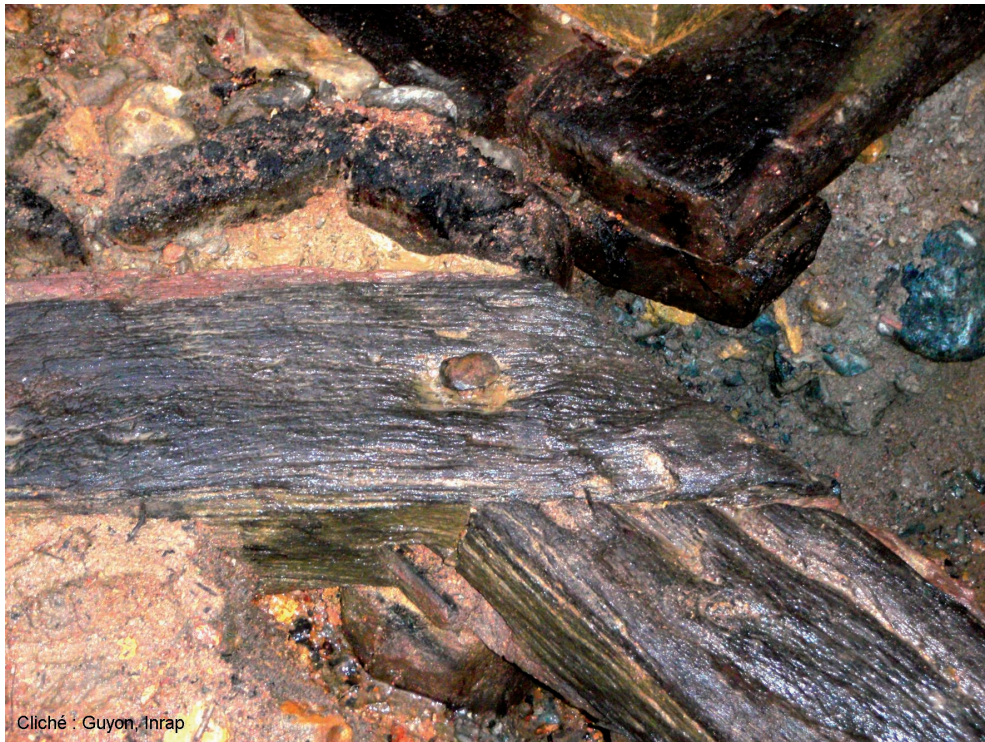
Fig. 29 : Détail de la liaison des demi-moises par un clou (cliché : Guyon, Inrap).
