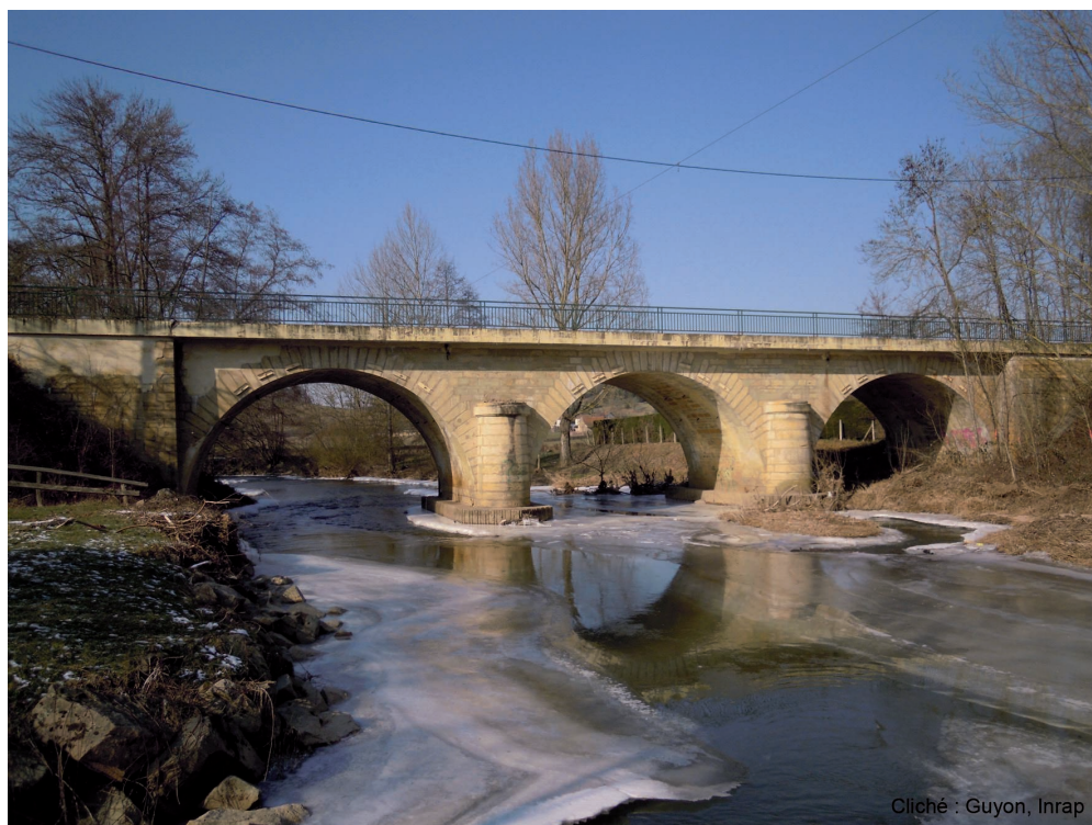
Fig. 51 : Pont de Pouilly-sous-Charlieu (cliché : Guyon, Inrap).
