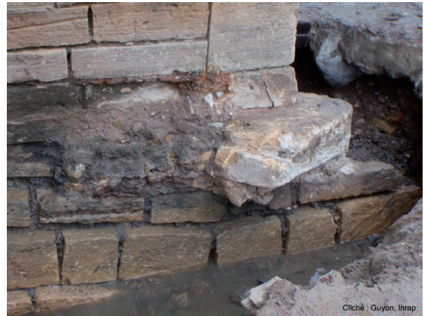
Fig. 41 : Consolidation de la fondation de l'avant-bec de la pile P4 (cliché : Guyon, Inrap).
