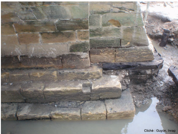
Fig. 42 : Encoche dans un bloc de fondation de la pile P4 (cliché : Guyon, Inrap).
