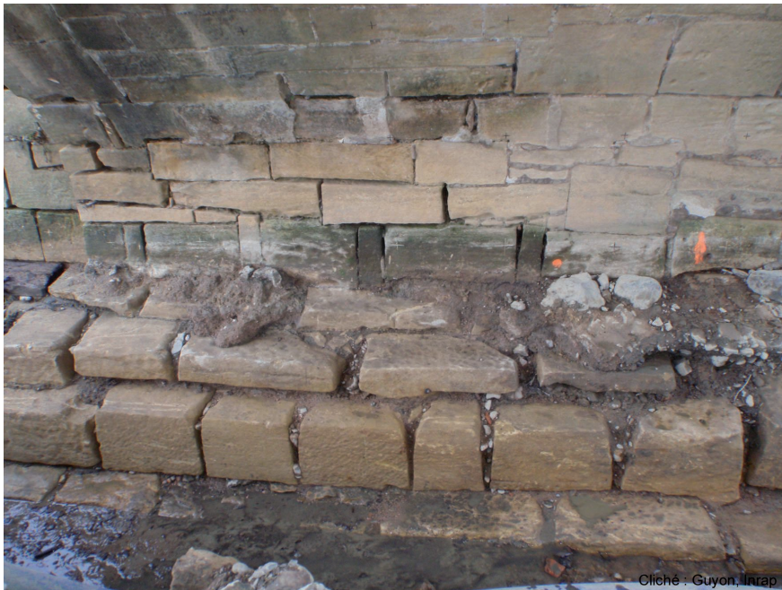
Fig. 38 : Fondation à degrés du piédroit nord de la pile P4 (cliché : Guyon, Inrap).
