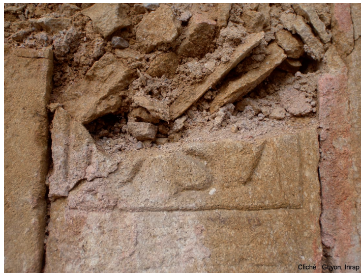
Fig. 21 : Date gravée sur la clé de voûte amont de l'arche A1 in situ (cliché : Guyon, Inrap).
