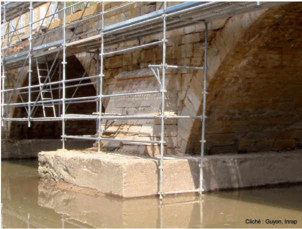
Fig. 8 : Arrière-bec de la pile P2 (cliché : Guyon, Inrap).
