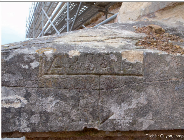
Fig. 18 : Repères altimétriques (relevé, DAO et clichés : Guyon, Inrap).
