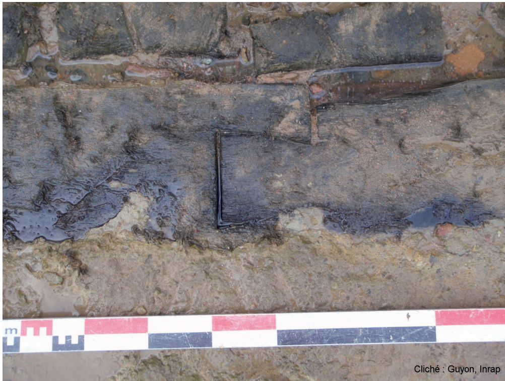
Fig. 27 : Détail de l'assemblage à queue d'aronde des demi-moises amont du radier au niveau de l'arche A3 (cliché : Guyon, Inrap).
