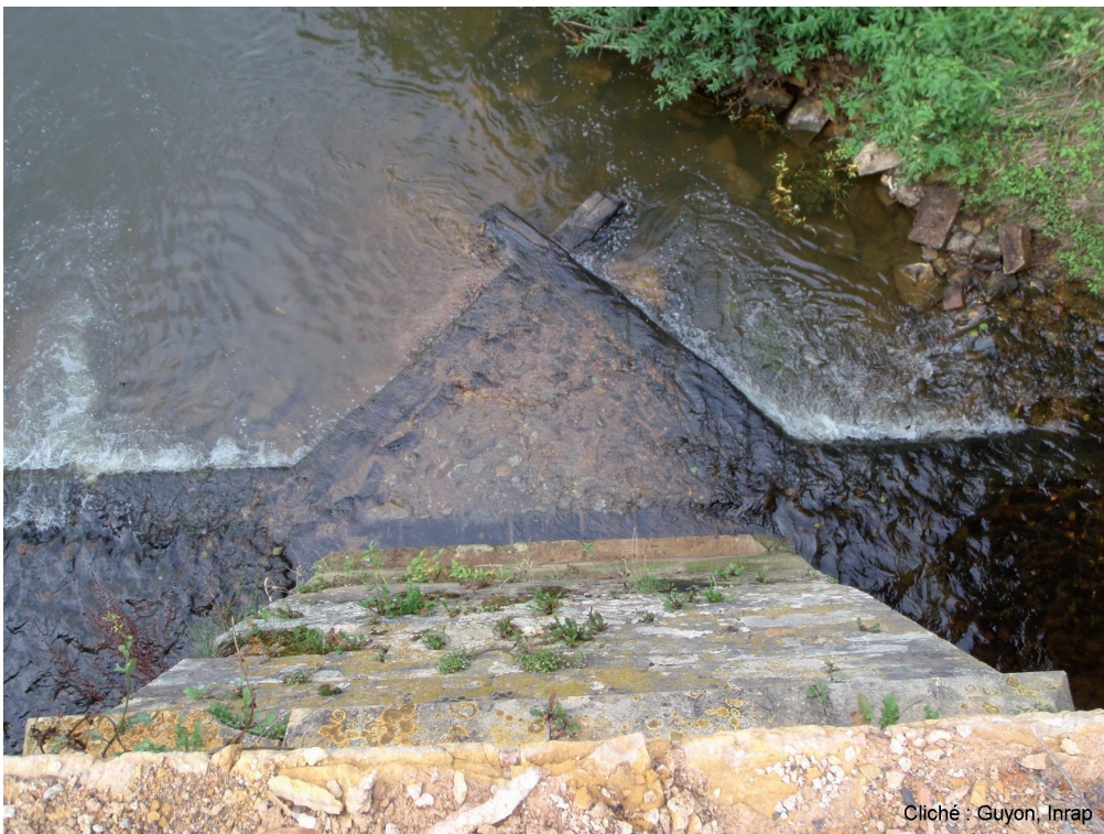
Fig. 28 : Arrière-bec de la pile P4 avant les travaux (cliché : Guyon, Inrap).
