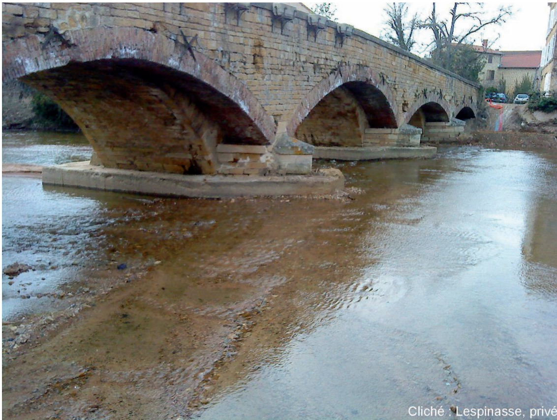
Fig. 3 : Façade amont du pont avant la démolition de l'élargissement vue depuis la rive gauche (cliché : Lespinasse, privé).
