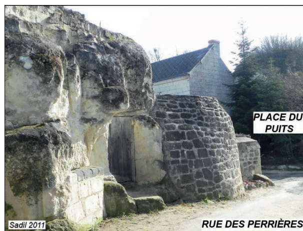
Fig. 17 : Mur de rempart appuyé sur l'éperon rocheux de tuffeau calcaire, rue des Perrières (extrémité est), Sadil 2011.
