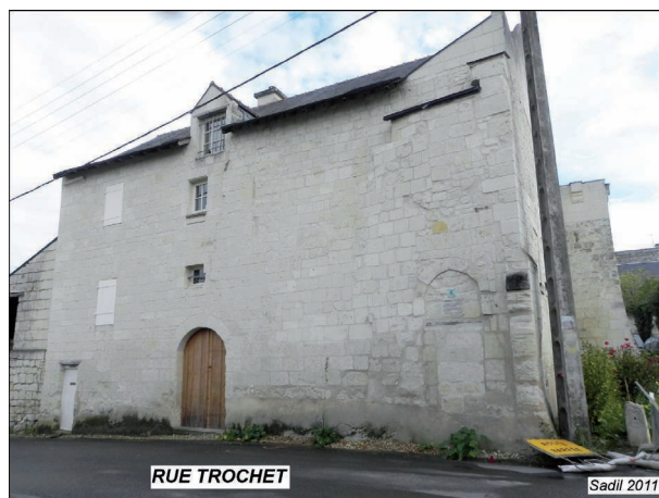
Fig. 15 : "Maison de la Garnison" ( xiii s. ?), rue Trochet, défendant la porte de Torché (ou de Terché) de la cité fortifiée, Sadil 2011.
