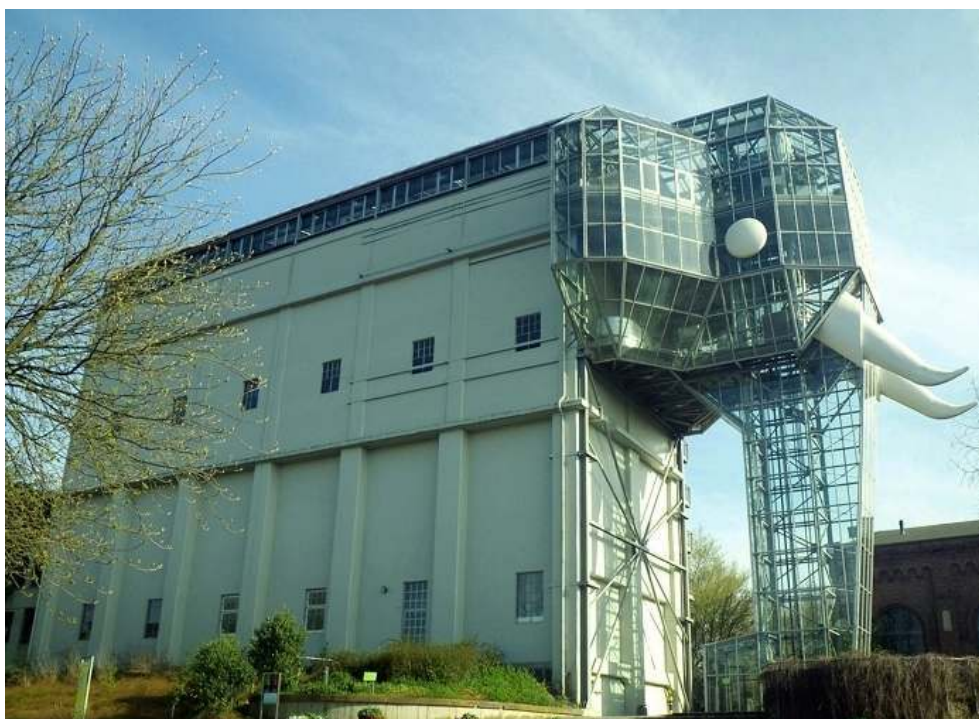
Figure 4. Le lavoir de Hamm reconverti en équipement culturel.
