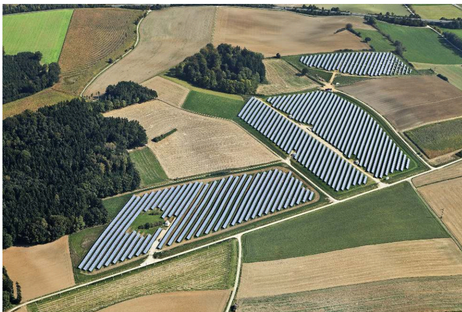
Photo 1 : parc photovoltaïque à Egglhausen en Bavière (photo : Klaus Leidorf)
