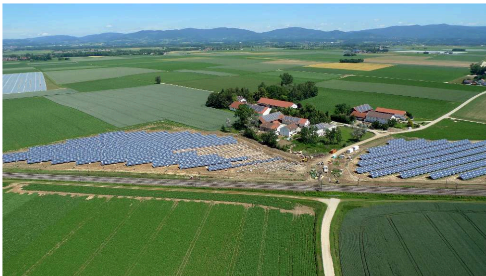
Photo 1 : parc photovoltaïque en Basse Bavière
