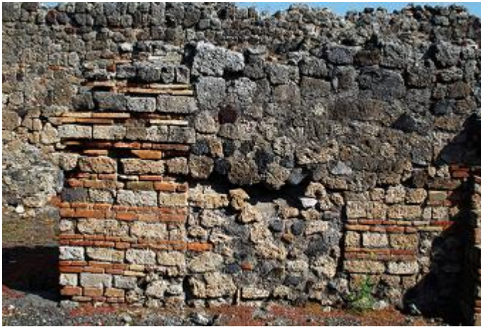
Fig. 19 – Pompéi, boulangerie VII 1, 36-37 – Mur oriental de l'atrium montrant le bouchage d'une porte initialement encadrée par des montants en opus vittatum mixtum .
