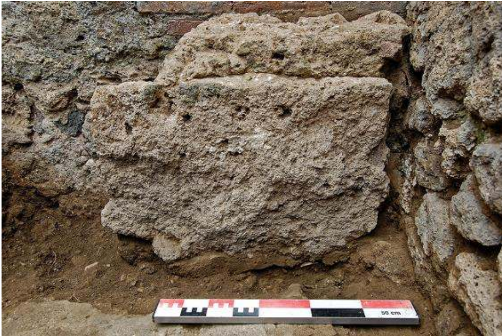
Fig. 55 – Pompéi, boulangerie VII 2, 11 – Pied de table maçonné, remployant un fragment de mur.
