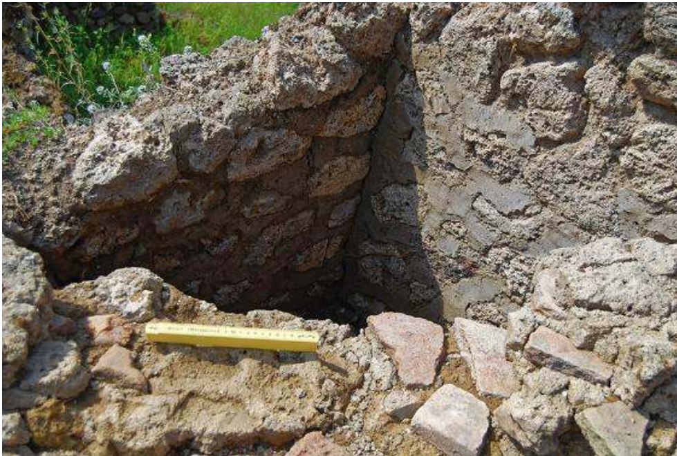
Fig. 12 – Pompéi, boulangerie I 3, 27 – Espace laissé libre entre le mur contenant le four et celui formant la coupole.
