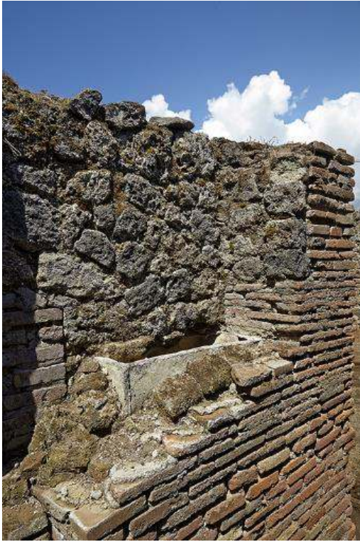
Fig. 50 – Pompéi, boulangerie VII 2, 11 – Chauffe-eau incorporé dans le mur diaphragme du four dans une seconde phase.
