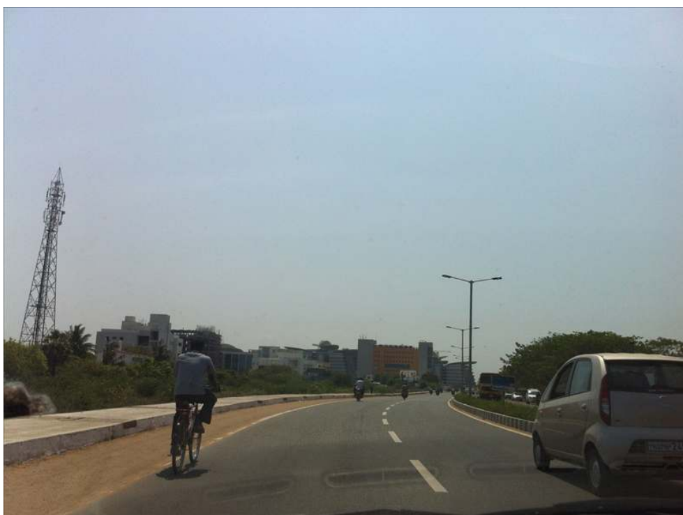
Illustration 3 – Vélo sur la bretelle d'accès reliant l'autoroute de l'informatique (IT Highway) et la Zone Économique Spéciale de Siruseri, au sud de Chennai (Inde)
